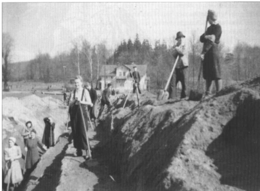
Bau eines Panzergrabens an der Gaststätte „Waldhaus“ bei Hertigswalde im April 1945
